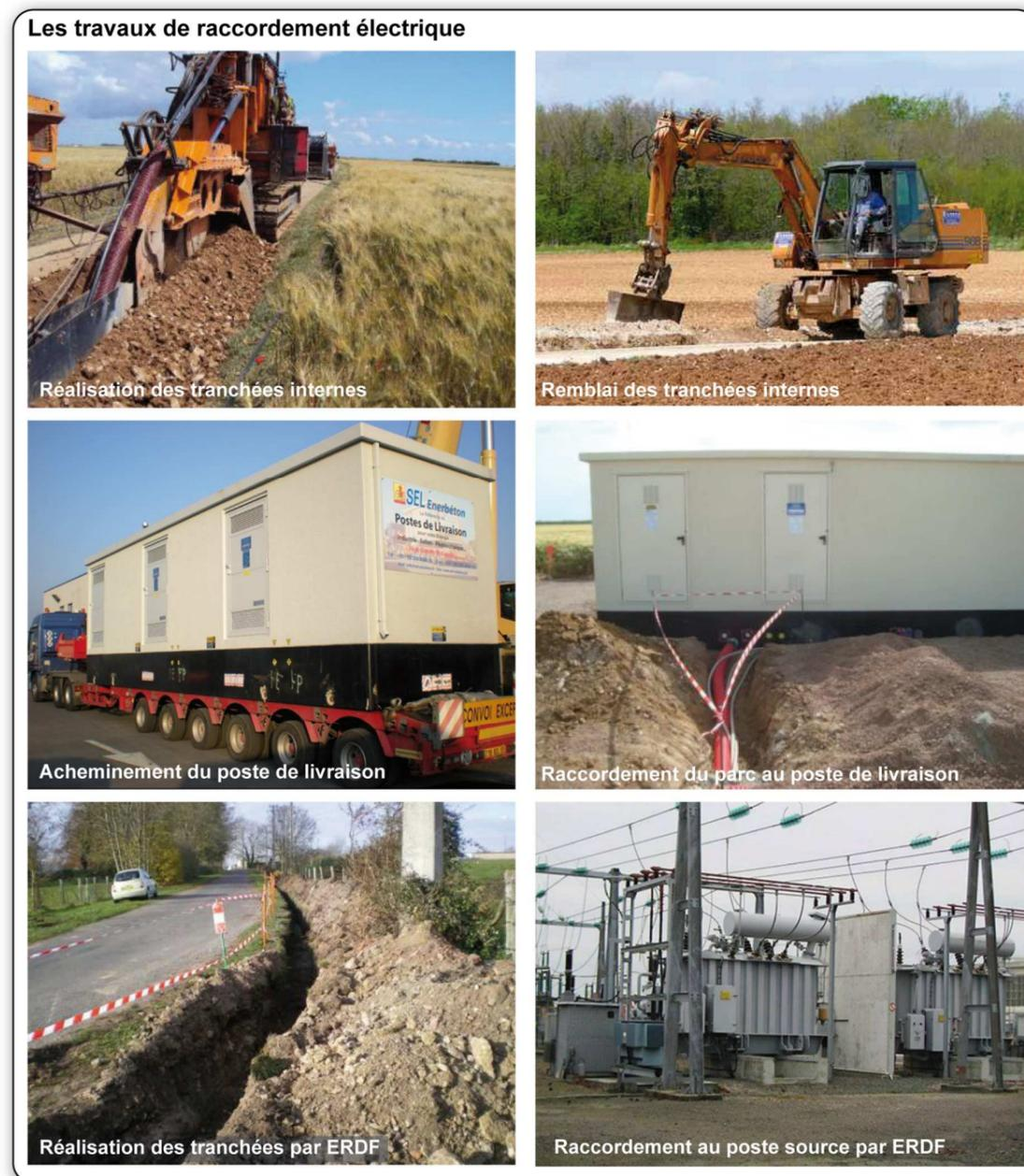
Photographie 11 : Travaux de raccordement électrique
