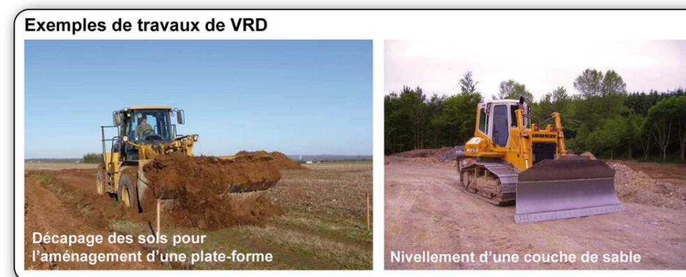
Photographie 9 : Exemples d'engins de travaux de VRD
